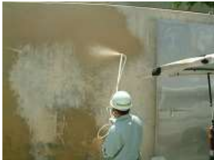
焼却灰保管ピット
