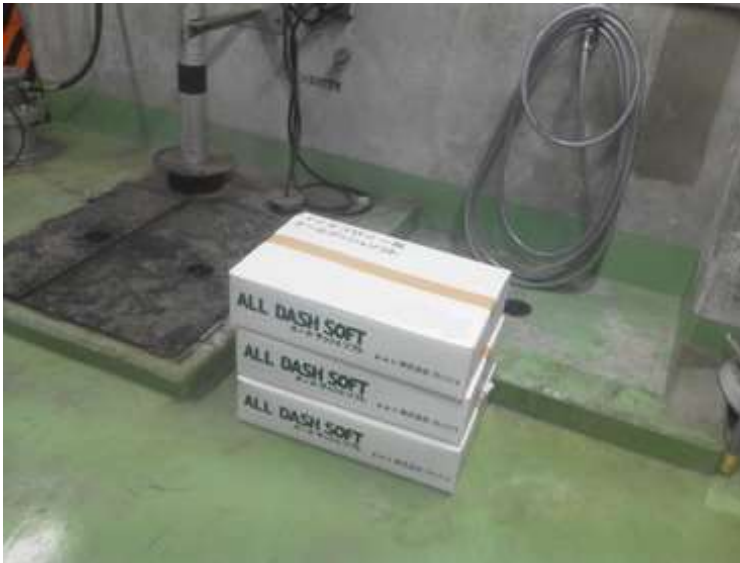
地下汚汁ピット開口部
