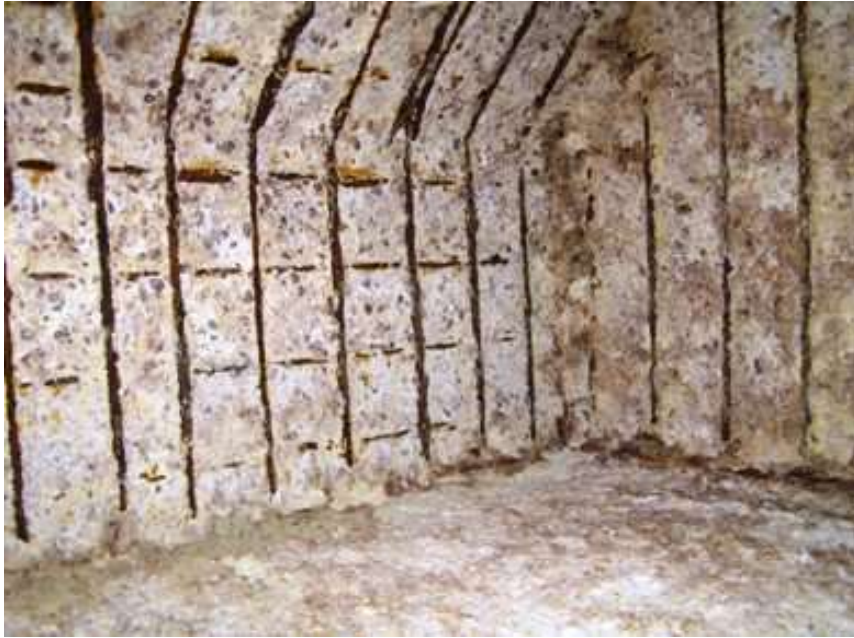
硫化水素によるコンクリート劣化
