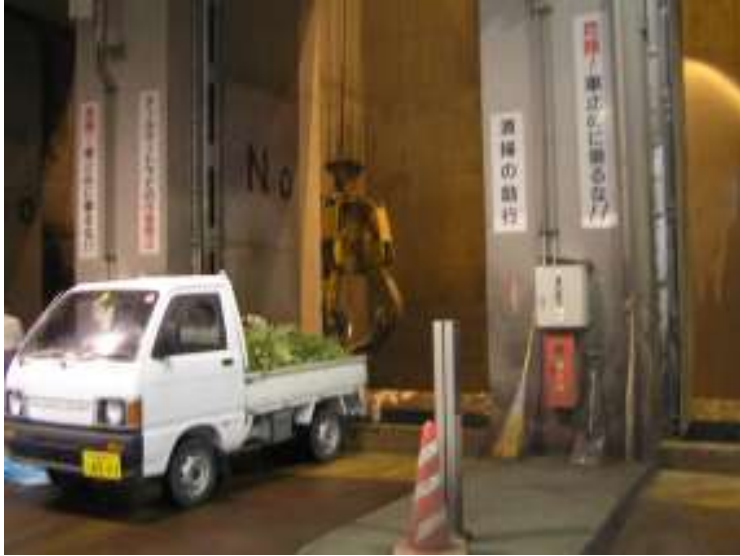
ごみ投入プラットフォーム
