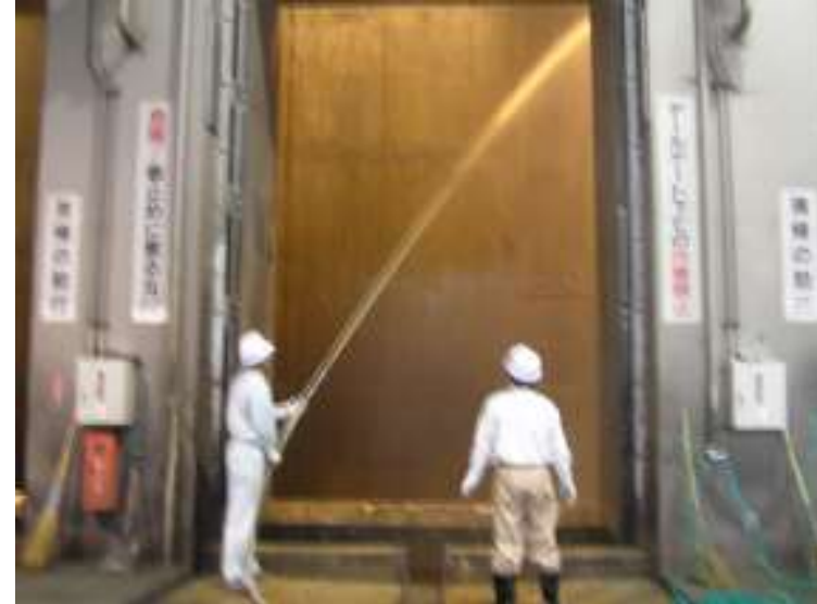
ごみピット脱臭養生吹きつけ
