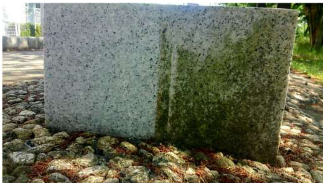
処理完了乾燥状態
